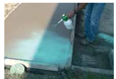
3. Aplicarea produsului CSK Disattivante
