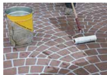
6. Aplicarea rășinii Sealfloor 100
