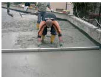
1. Turnarea si nivelarea betonului
