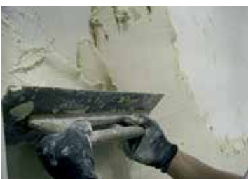
1. Aplicarea mortarului Decowall
