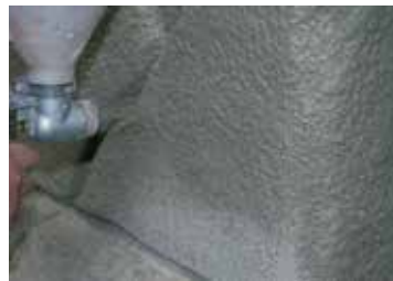
2. Al doilea strat de Rockwall
